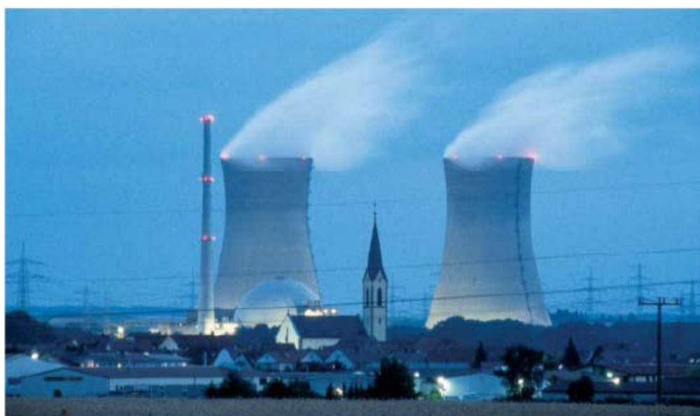
Abbildung 4-2 Ansicht des Kernkraftwerks Grafenrheinfeld
