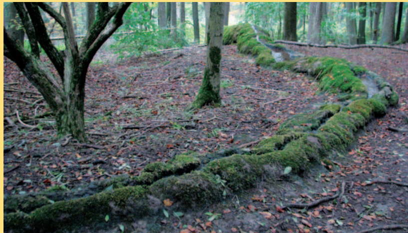
E16 | Eine steinerne Rinne aus Kalktuff südlich von Erasbach bei Berching (Oberpfalz).
